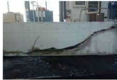
2. Picado de la grieta a cortante
