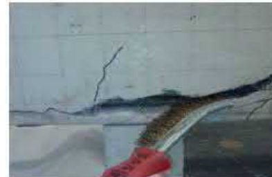
3. Cepillado manual de las armaduras
