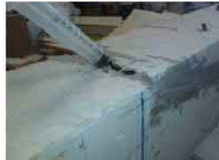
7. Inyección de resinas epoxi en cabeza de compresión
