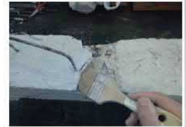
4. Limpieza de la zona a reparar
