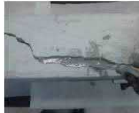
6. Reparación mediante mortero con resinas por las 2 caras de la viga
