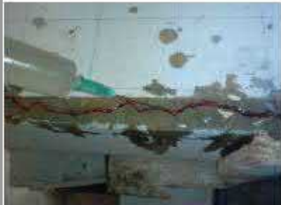
5. Inyección de resinas epoxi
