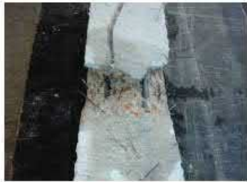
1. Picado de la cabeza de compresión
